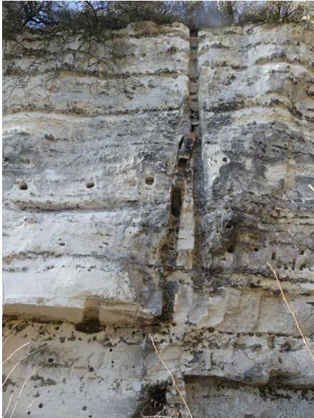
Traces de conduit de cheminée
