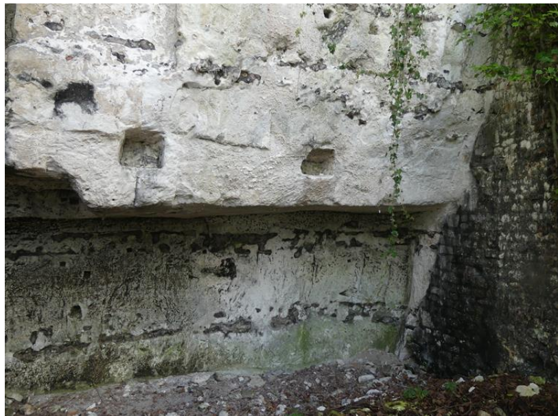
Restes de mur
