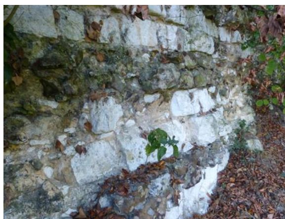
Vestiges de murs
